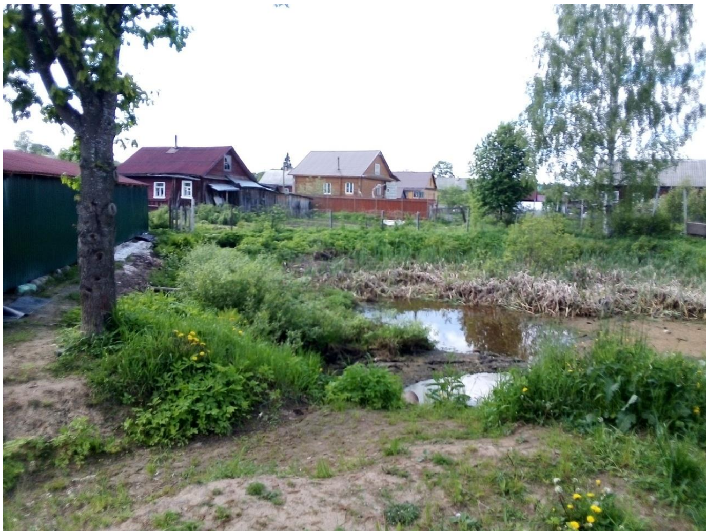
Расчистка пожарного водоема на переулке Лесном у домов 7, 9
